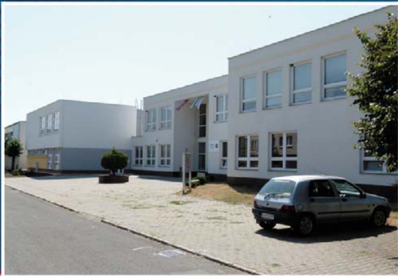
Základná škola Dudince
