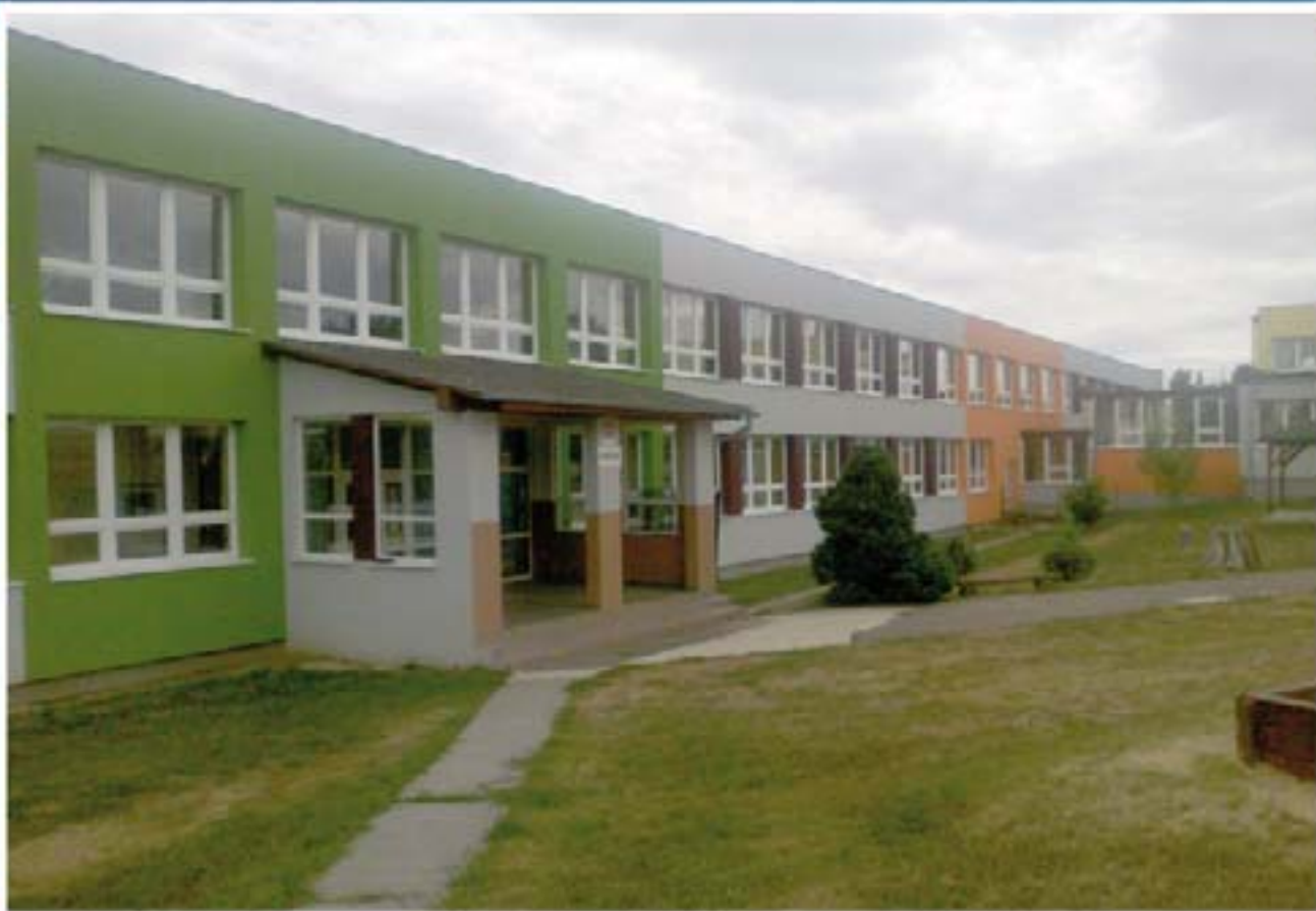
Základná škola Bojná
