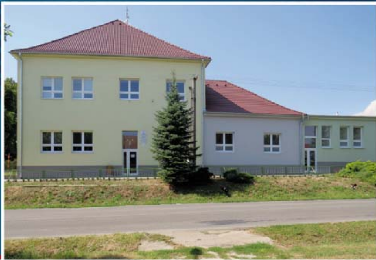
Základná škola Ružindol
