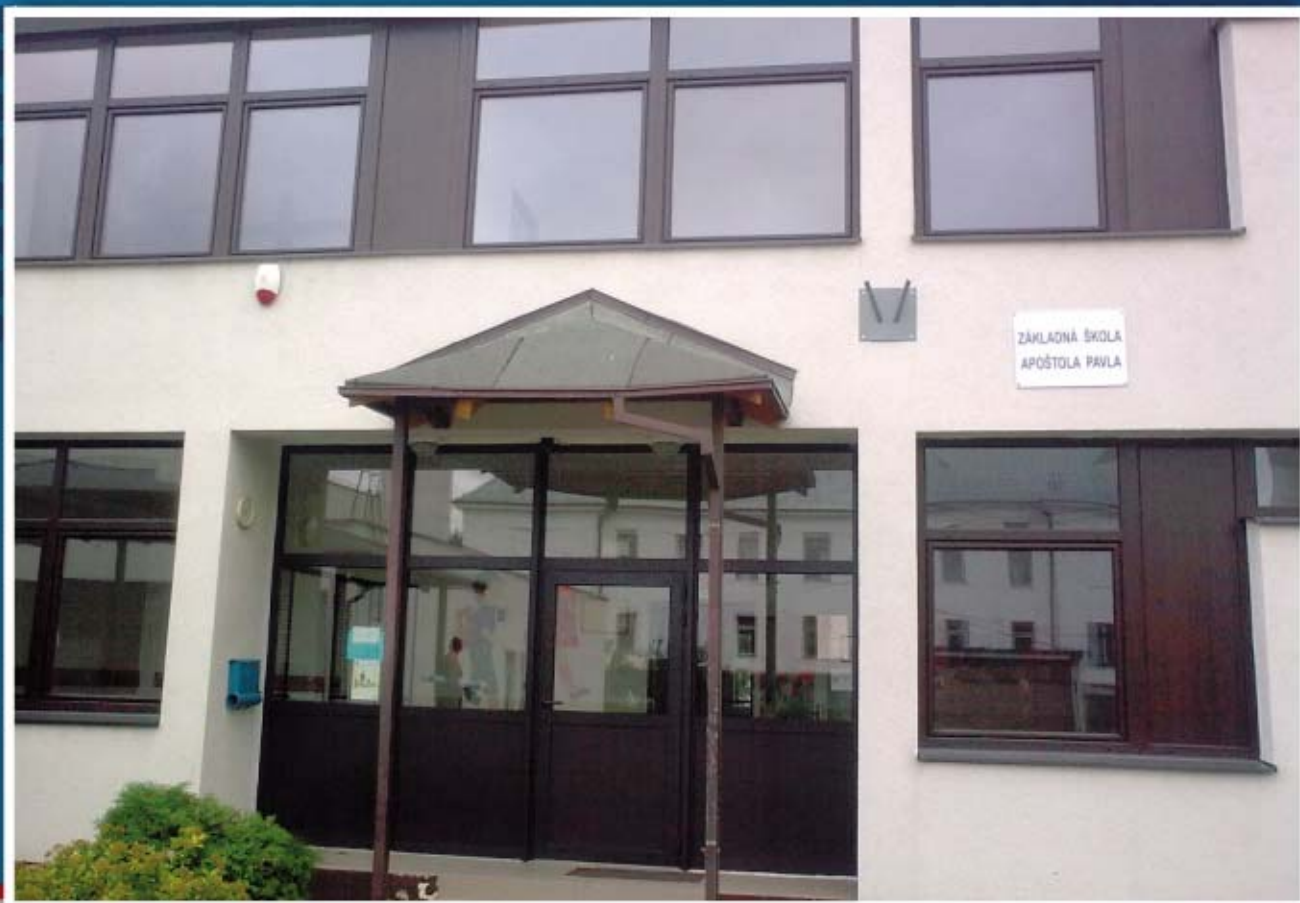
Základná škola Apoštola Pavla Liptovský Mikuláš
